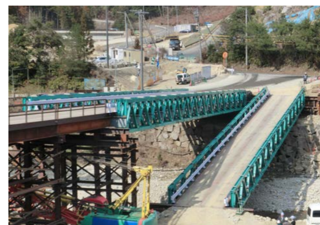
三重県/賀田地区整備工事 幅員:6.0m、橋長:45.0m 42号古川高架橋右岸下部工事 幅員:4.0m、橋長:45.0m
