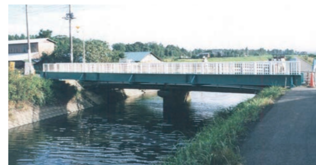
千葉県/市場橋 幅員:2.0m、橋長:23.0m
