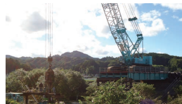
岩手県/一般国道106号宮古西道路長沢川橋梁下部工工事 幅員:8.0m、橋長:16.0m
