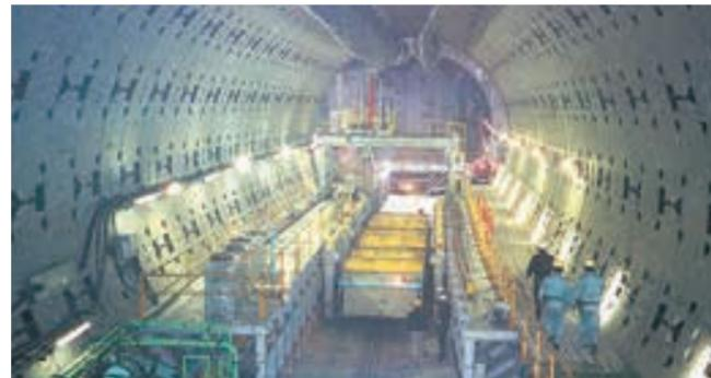
●泥水処理設備架台
