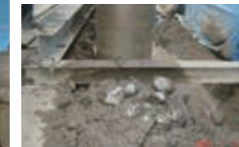
▼撤去された地中障害
