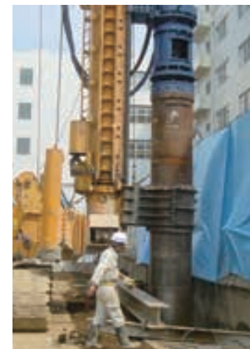
◀ロックオーガー工 三点杭打機
