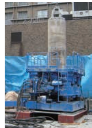
◀地中障害撤去工 全周回転掘削機
