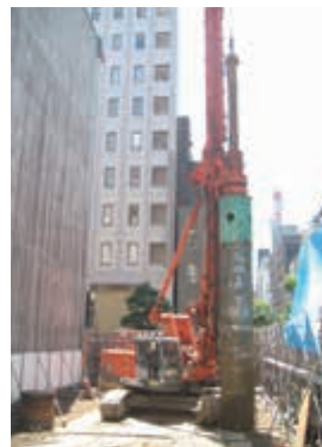
◀地中障害撤去工 BG掘削機
