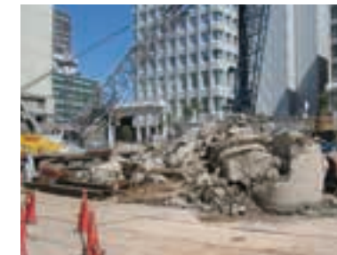
▼撤去された地中障害
