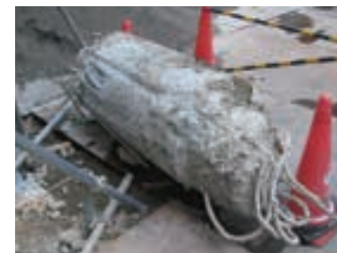
▼撤去された地中障害
