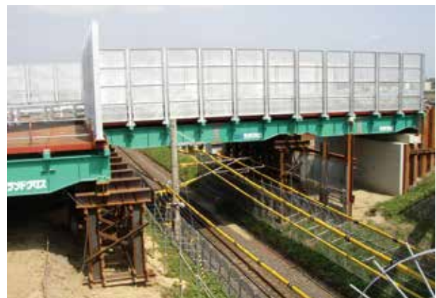
三重県/亀山市 幅員：10.0m (一部20.0m)、橋長：32.0m (3径間)
