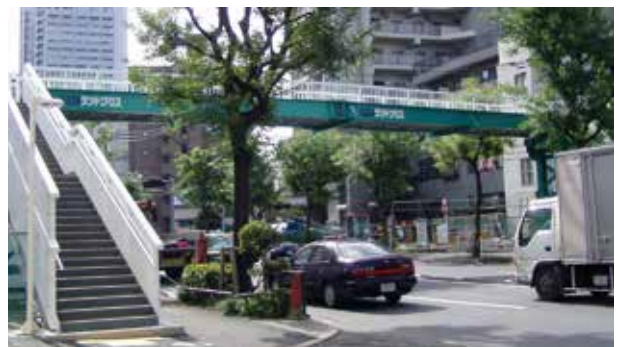
東京都/中野坂上歩道橋 幅員: 2.0m、橋長: 21.0m
