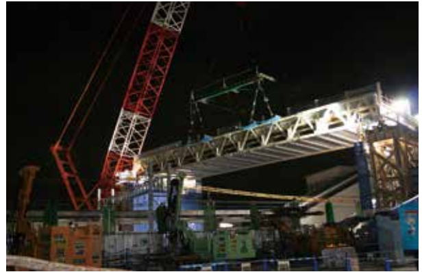
事例2:トラス橋(跨線橋)の一括架設
