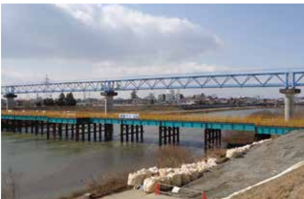
宮城県／迫川水管橋災害復旧工事 幅員：8.0m、橋長：110.0m(11径間)
