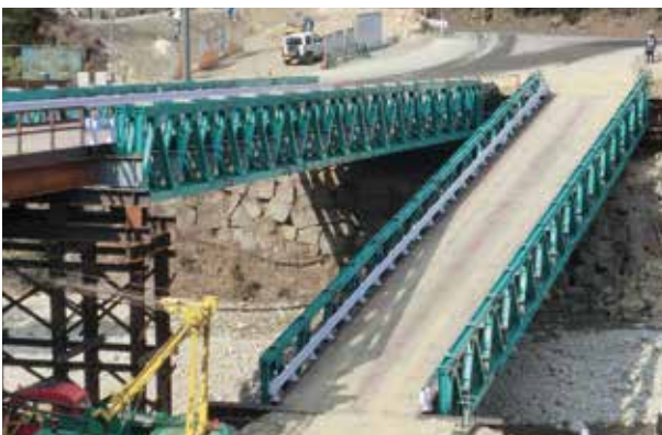
三重県／賀田地区整備工事 幅員：6.0m、橋長：45.0m 42号古川高架橋右岸下部工事 幅員：4.0m、橋長：45.0m
