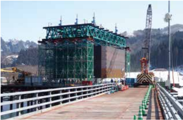
事例1:ニューマチックケーソンの吊下げ用架台
