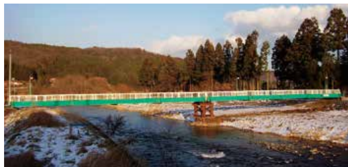
青森県/法量橋 幅員: 2.0m、橋長: 50.0m(2径間)
