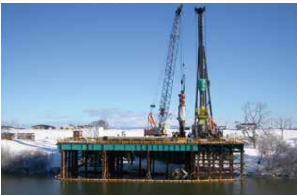
事例4:大型杭打ち機用作業架台(钣桁TYPE I 使用)
