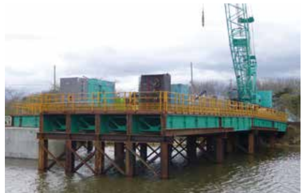
青森県／町道410号線(花切橋)下部工事 幅員：8.0m、橋長：40.0m(4径間)+14.0m
