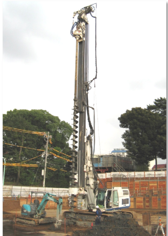
▲ RG杭打機 削孔注入仕様
