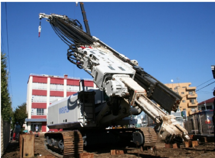
▲ RG杭打機 リーダー-収縮引き倒し状況
