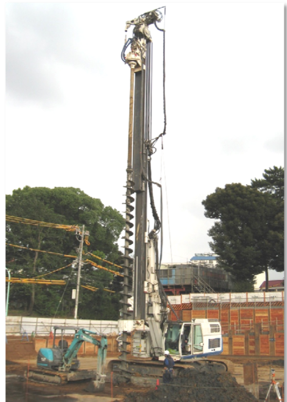
▲ RG杭打機 削孔注入仕様
