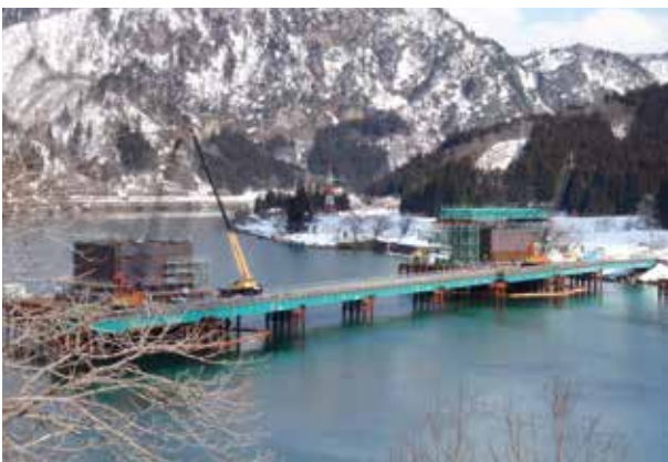
新潟県／東蒲原郡 幅員：6.0m (一部8.0m)、橋長：204.0m (8径間)
