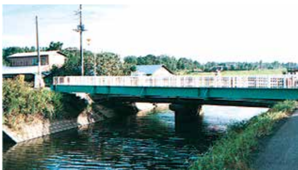
千葉県/市場橋 幅員：2.0m、橋長：23.0m
