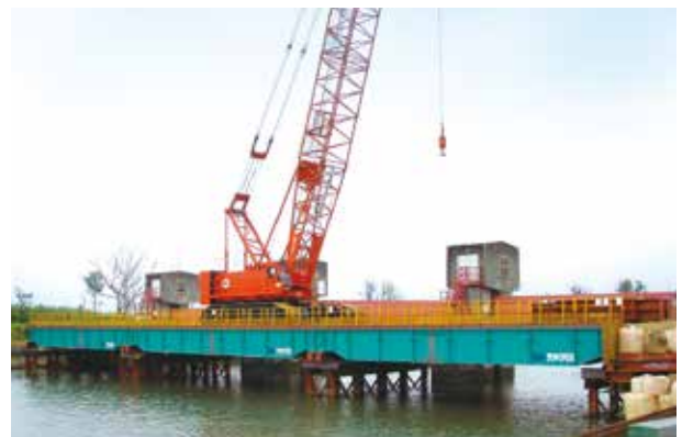
宮城県／貞山堀防潮水門旧施設撤去工事 幅員：8.0m、橋長：50.0m(3径間)
