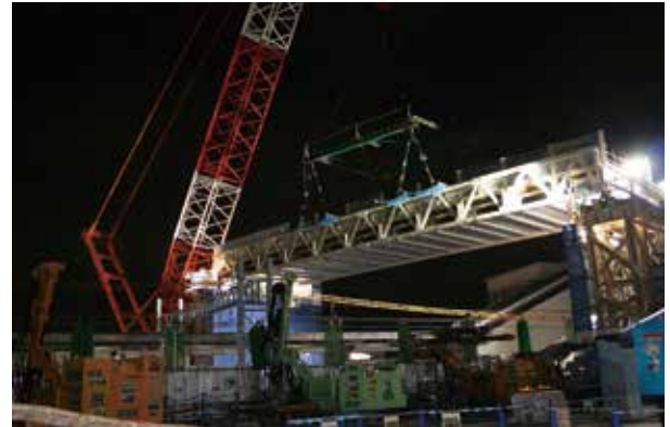
事例2：トラス橋(跨線橋)の一括架設
