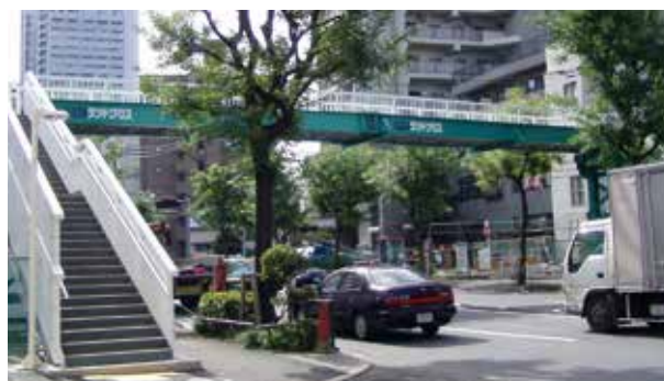
東京都/中野坂上歩道橋 幅員：2.0m、橋長：21.0m
