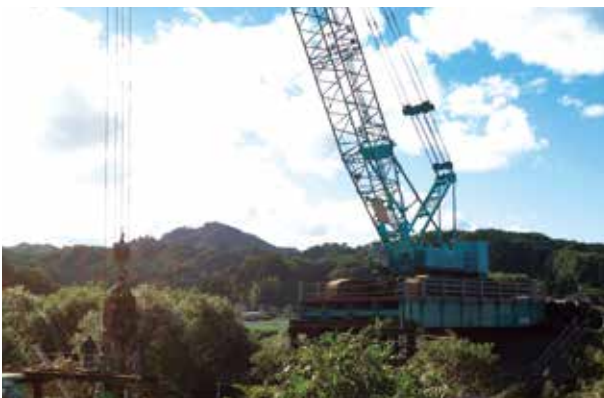
岩手県／一般国道106号宮古西道路長沢川橋梁下部工事 幅員：8.0m、橋長：16.0m
