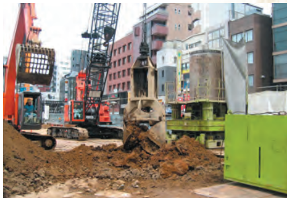
〈施工例〉地中障害撤去工事
