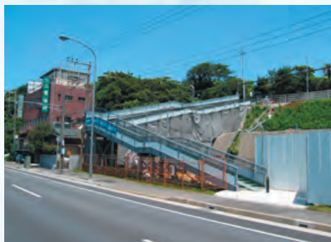
歩道橋設置工事
