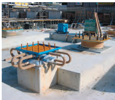
〈施工例〉免震装置据付工事
