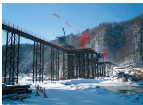
仮橋及び作業構台構築工事
