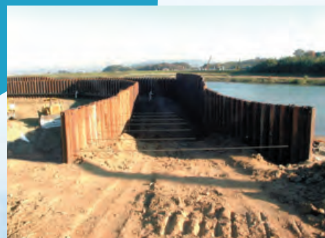
河川改修工事
