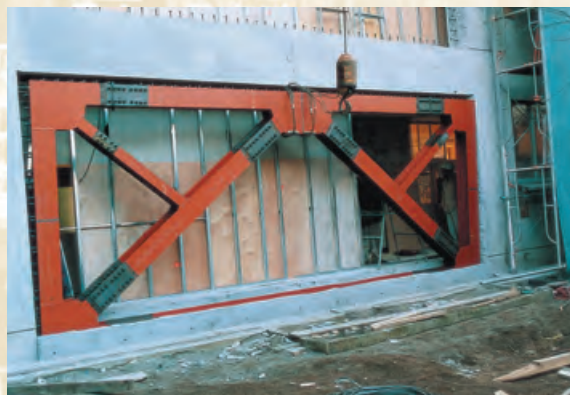
〈施工例〉鉄骨ブレース耐震補強工事
