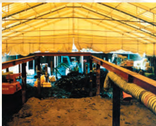
〈施工例〉汚染土壌対策工事
