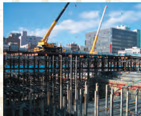
〈施工例〉重仮設工事
