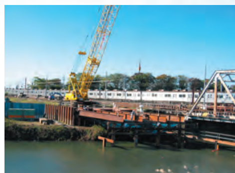
河川改修工事
