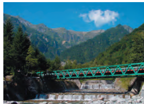
仮設橋梁 (ランドクロス)
