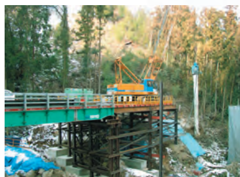
杭打抜工事 (ダウンザホールハンマー)
