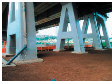
橋脚耐震補強工事 (鉄板巻立て)
