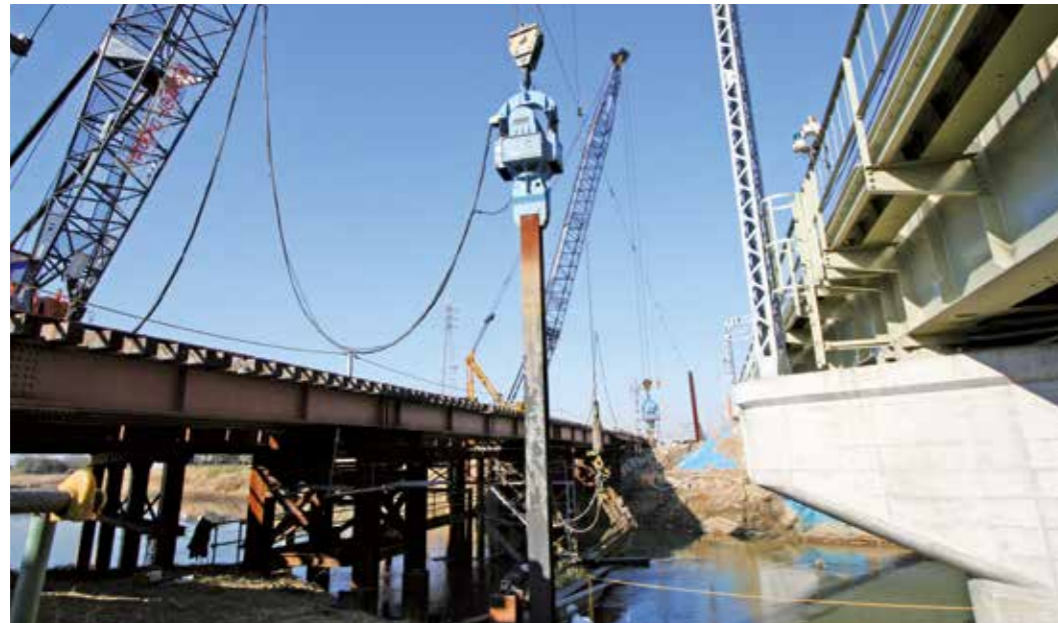
【施工フロー(クローラークレーン バイブロハンマー打込工)】
