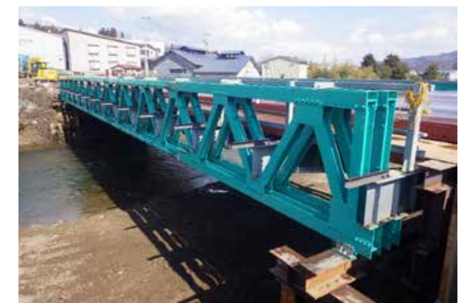
青森県/ 黄金橋 幅員:8.0m、橋長:39.0m
