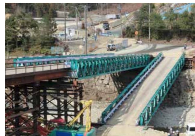
三重県/ 賀田地区整備工事 幅員:6.0m、橋長:45.0m 42号古川高架橋右岸下部工事 幅員:4.0m、橋長:45.0m
