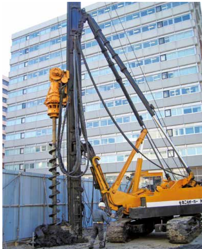
【施工フロー(ミニオーガー/パイルマン杭打機 同時削孔圧入工)】
