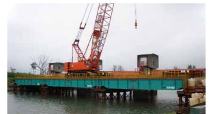
宮城県/貞山堀防潮水門旧施設撤去工事 幅員:8.0m、橋長:50.0m(3径間)
